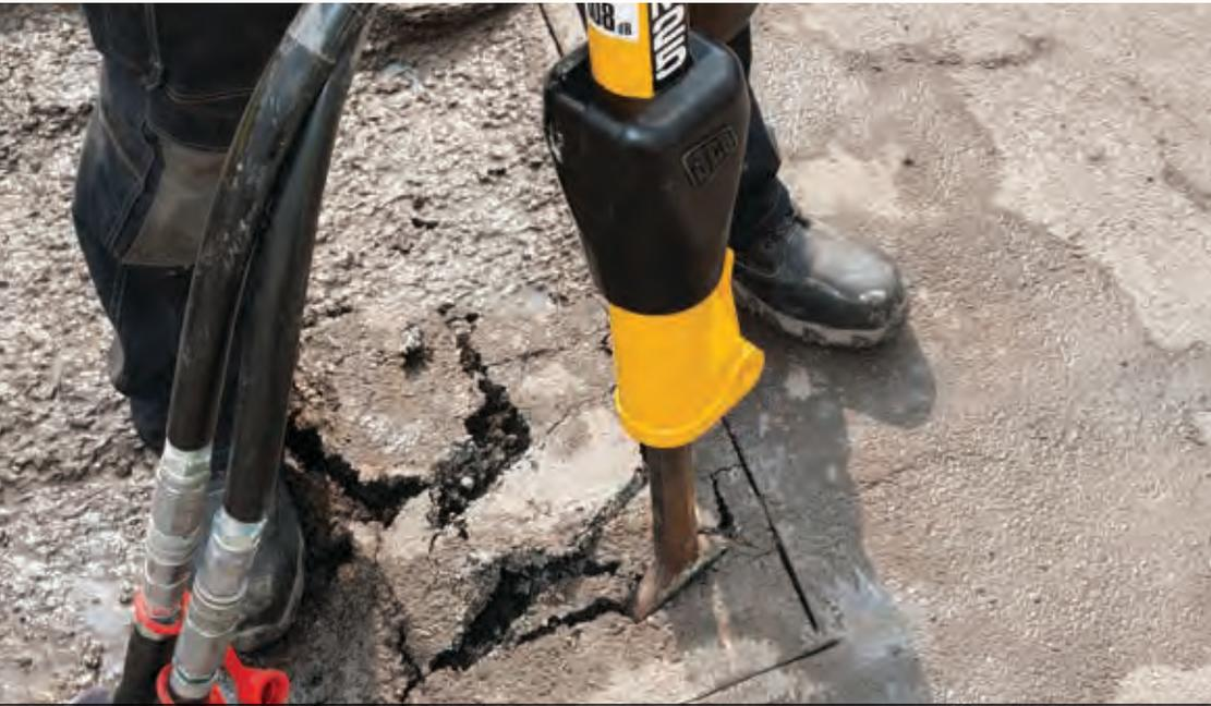
3. **DECOUPE** | La JCB 3CX peut être équipée d'un marteau-piqueur pour effectuer les finitions et gagner du temps.
