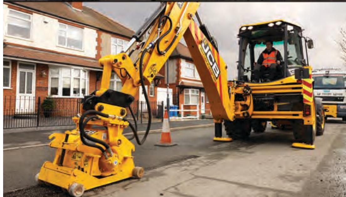
2. DEBUT DU RABOTAGE | La raboteuse permet d'effectuer un rabotage de précision jusqu'à une profondeur maximale de 115 mm.
