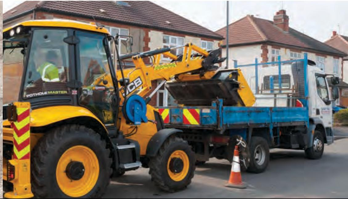
5. **NETTOYAGE** | La JCB 3CX permet de décharger les déblais dans le camion-benne avant de passer à la tâche suivante.
